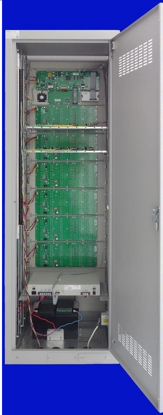
图 5 JBF-61S20-G 柜式机内部结构图
